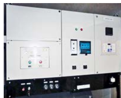
高圧搭載形発電機自動始動盤
